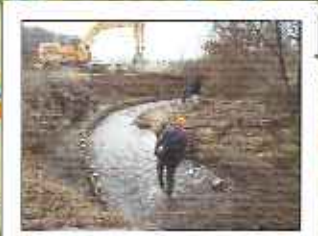
Chantier de stabilisation de berge du Volvon à St Bonnet les Oules [février 2003]
