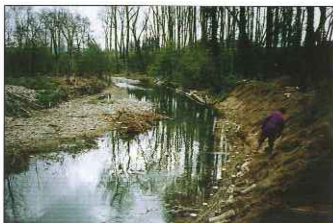
Pieux et fagots de saule pour redessiner la berge
