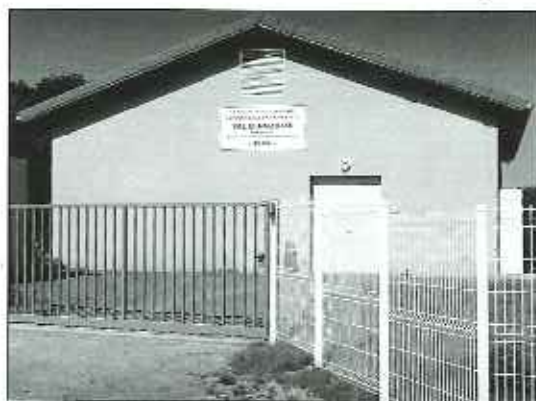
Réservoir rassemblant les ressources en eau potable du Val d'Anzieux
