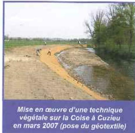
Mise en œuvre d'une technique végétale sur la Coise à Cuzieu en mars 2007 (pose du géotextile)
